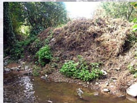
Fragilisation de la berge et développement des orties
